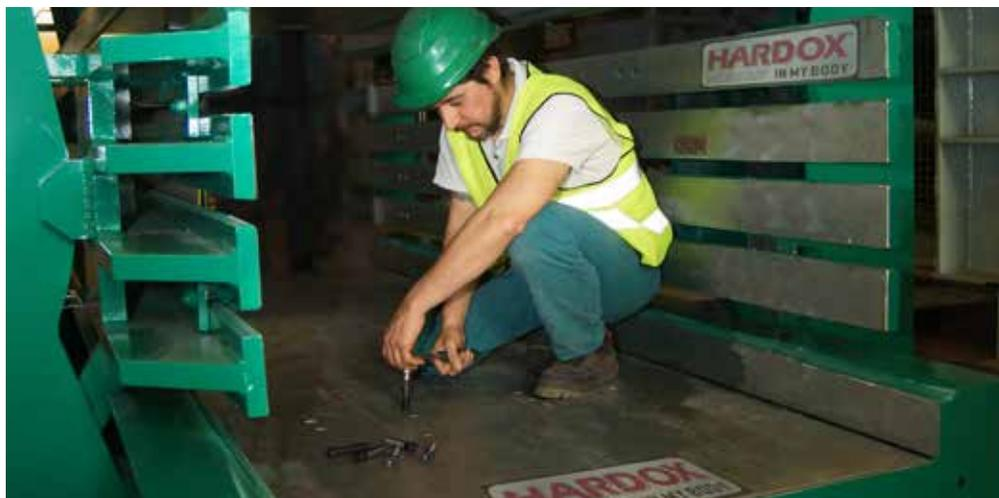
Os revestimentos resistentes ao desgaste Hardox são aparafusados no canal de travagem e na caixa de compactação e podem ser substituídos facilmente.
